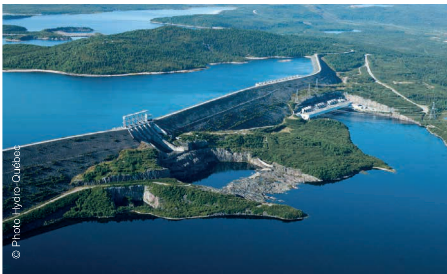
Área de presa en CH La Grande-3
