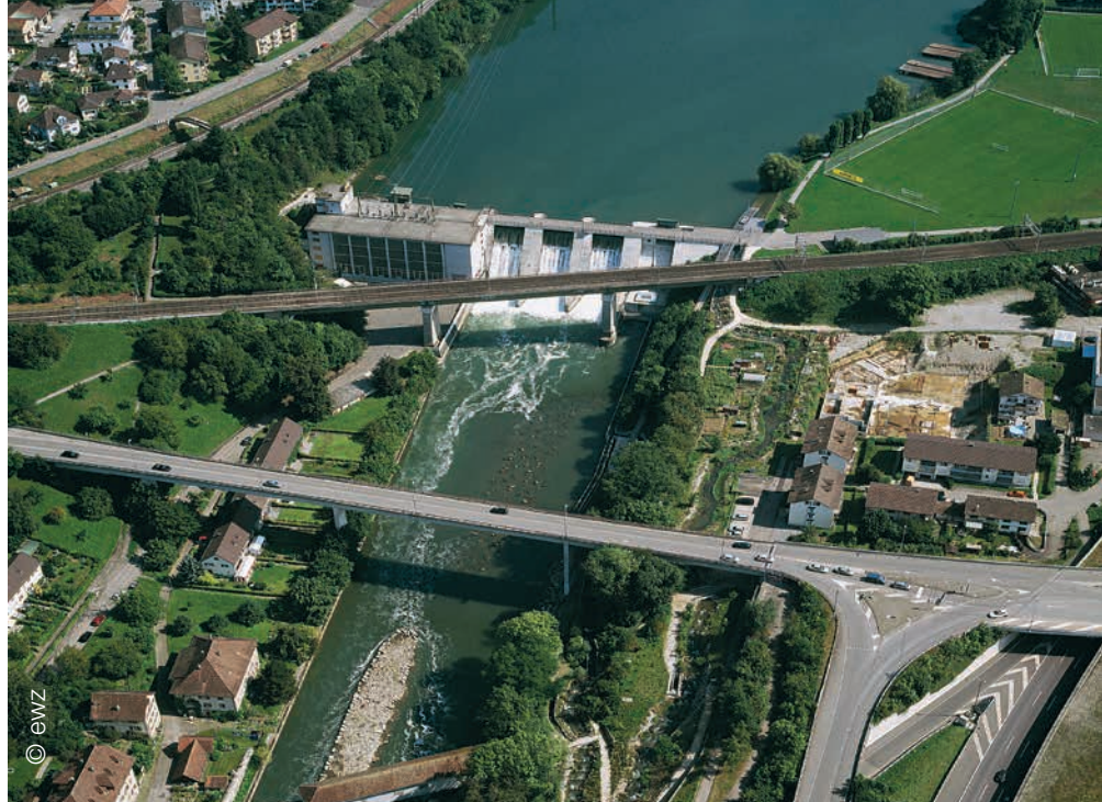
Vista aérea de la casa de máquinas y presa
