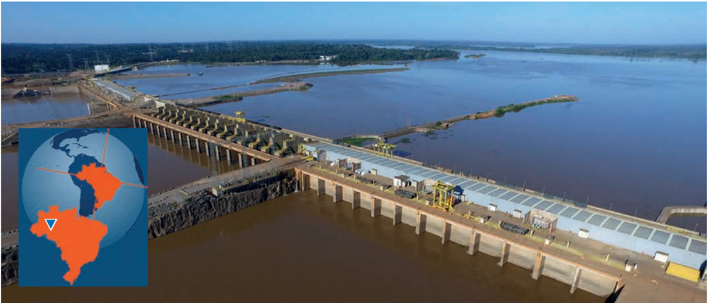
Casa de máquinas y área de presa
