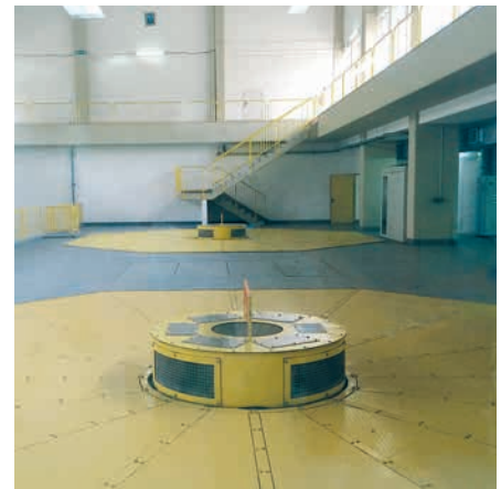
Sala de máquinas antes de la rehabilitación
