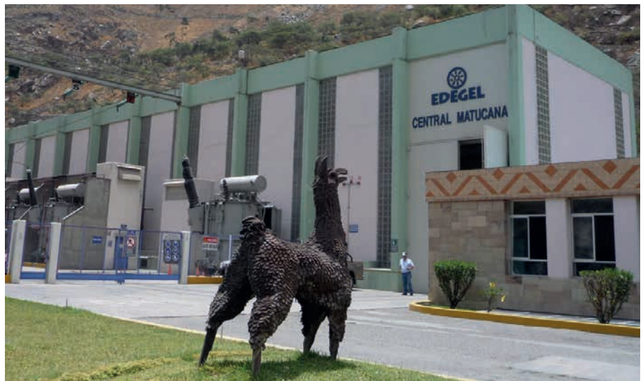
Casa de máquinas de CH Matucana
