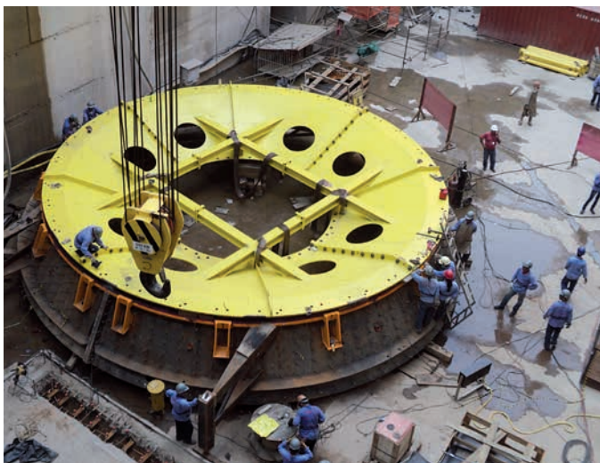
Trabajos de montaje
